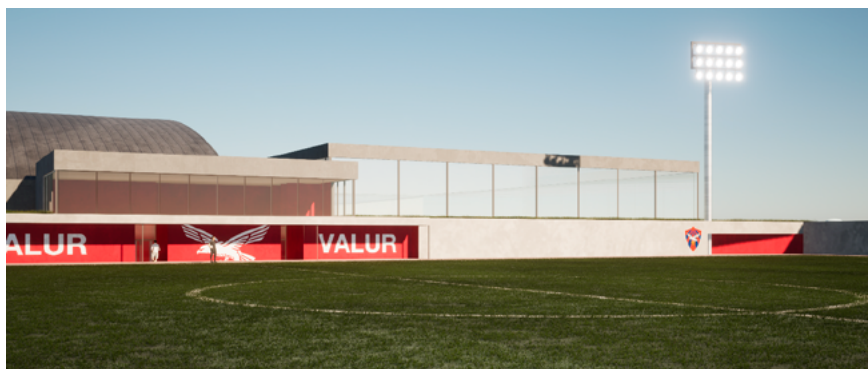
Fjölnota íþróttahús, horft frá áhorfendastíku leikvangs.
