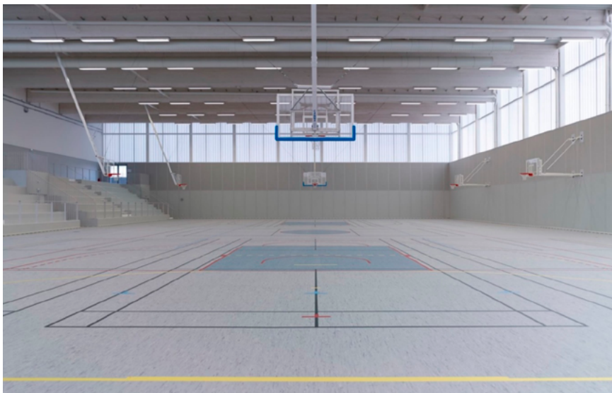
Íþróttahús í úthverfi Parísar, arkitekt Martin Duplantier.
